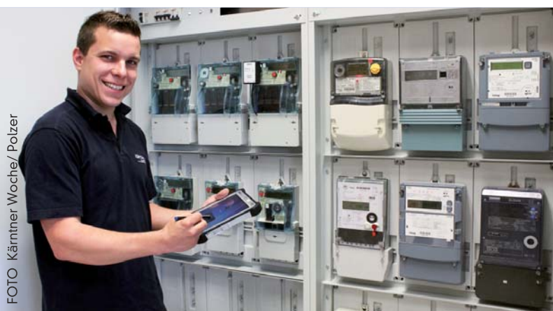
KNG-Kärnten Netz GmbH Zählermonteur Christoph Kopp bei der Auslesung eines elektronischen Zählers mittels Tablet und Bluetooth Auslesekopf.
